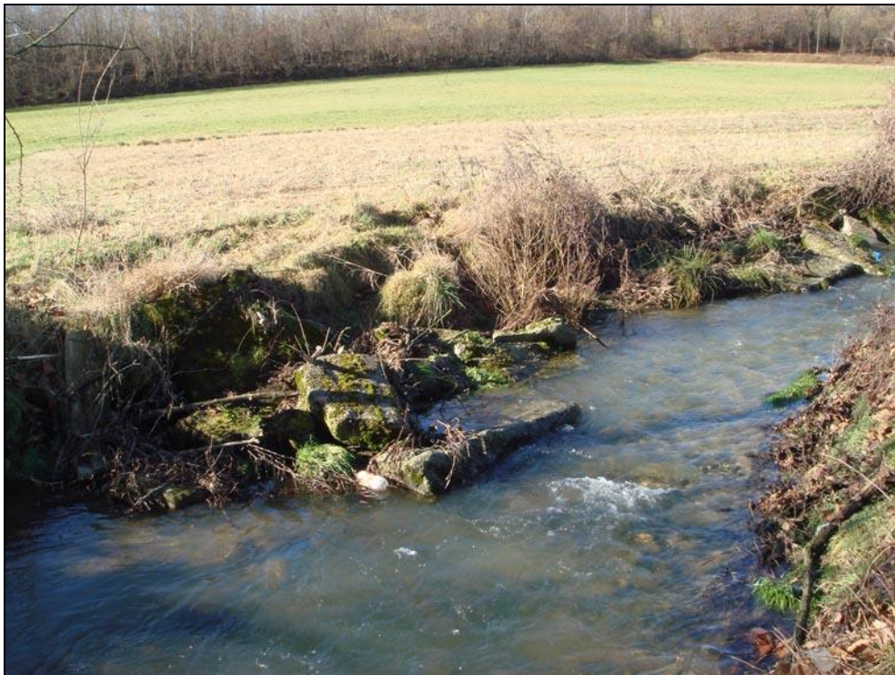
Foto 1: T. Lavandaia destra e sinistra idrografica: franamento/arretramento ciglio spondale e opere di difesa ammalorate che occludono parzialmente la sezione di deflusso
