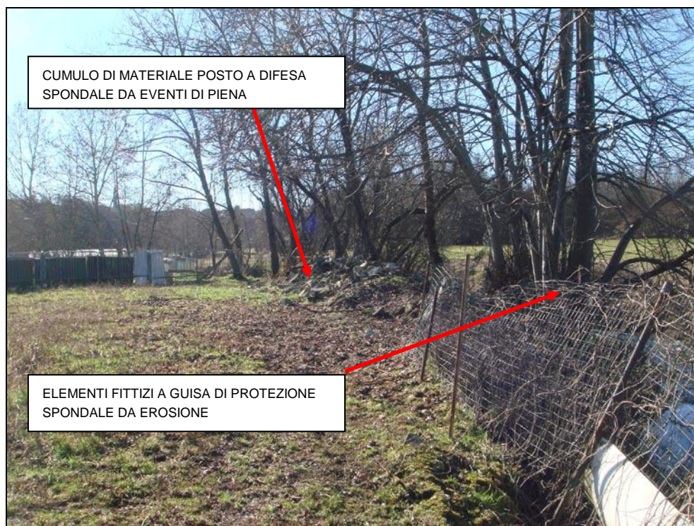
Foto 3: T. Lavandaia in sponda sinistra idrografica all'altezza allevamento suini: ciglio spondale in erosione protetto da elementi approssimativi e presenza di un cumulo di materiale a guisa di protezione spondale da eventi di piena
